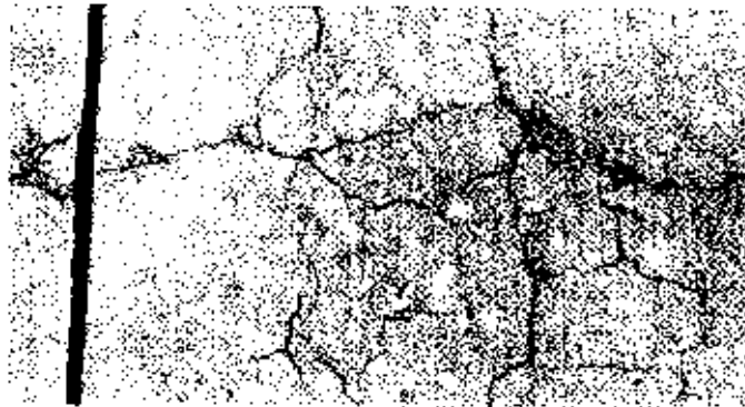
Bild 1: Plastischer Schwundriss im Beton
