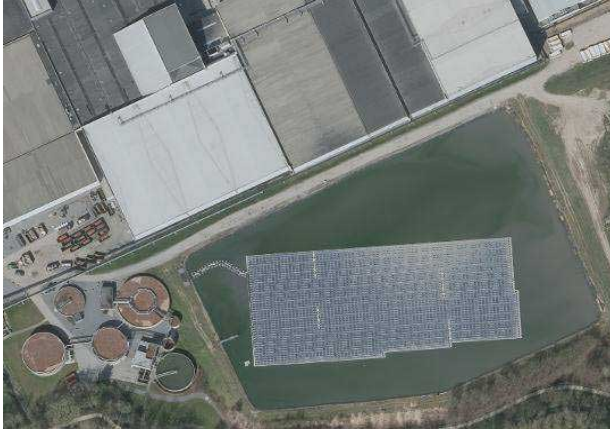
Fotovoltaïsch project in industriegebied
