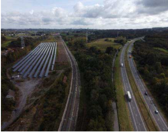
Fotovoltaïsch project op de site van een voormalig rangeerstation
